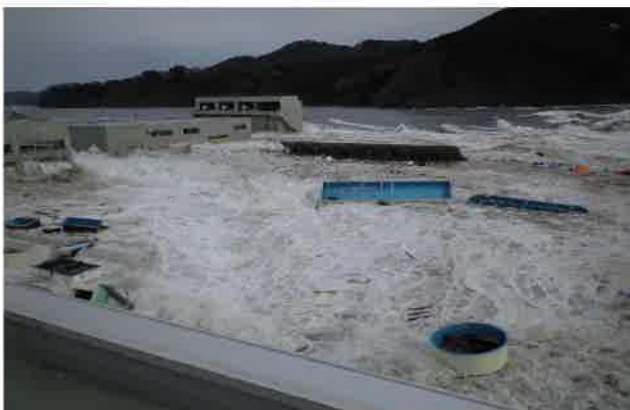
敷地内の屋外水槽等が流出
